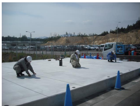
Figura 15 - Preparação da fundação (Acervo pessoal)
